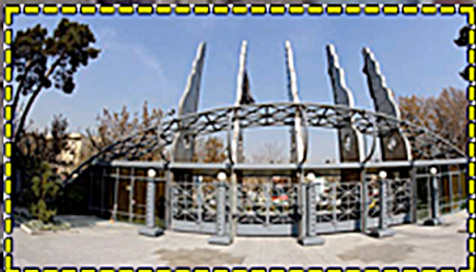
Entrée Nord de la Salle Vahdat
